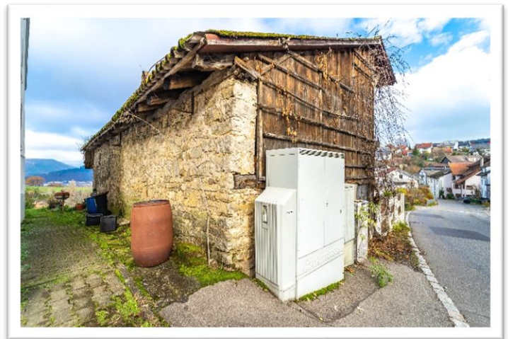
Grenzbebauung / alte Bruchsteinmauer
